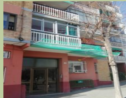
Suport processos de rehabilitació
