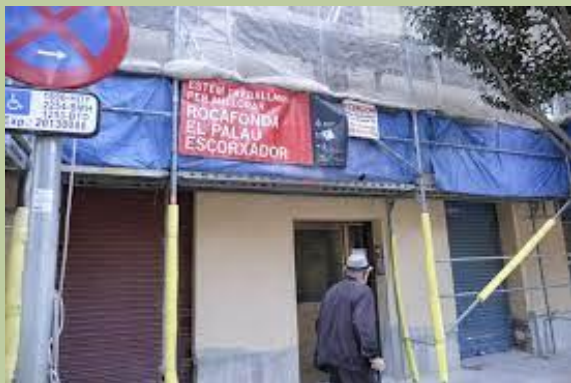
Suport tramitacions ajuts de rehabilitació
